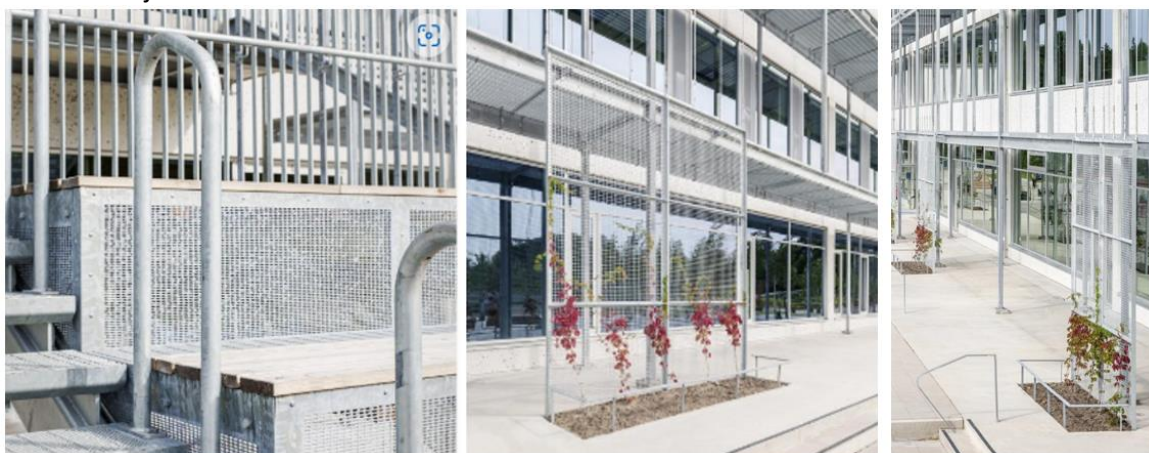
Figur 14: Inspirationsbild som visar hur gradängerna med sittplatser runt scenen kan utformas med hjälp av robusta material som till exempel förzinkade / aluminiumraster. Liknande raster/ställning kan användas för klättrande växter som bryter ned den långa fasaden, gör att byggnaden smälter in i naturmiljön samtidigt som den utgör ett solskydd för utemiljön i södra läget. Bildkällan: Tengbom, Fornuddens skolan, Tyresö
