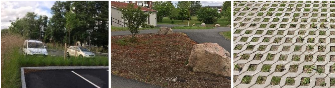
Figur 10: Bilderna visar exempel på gröna, genomsläppliga parkeringsytor
